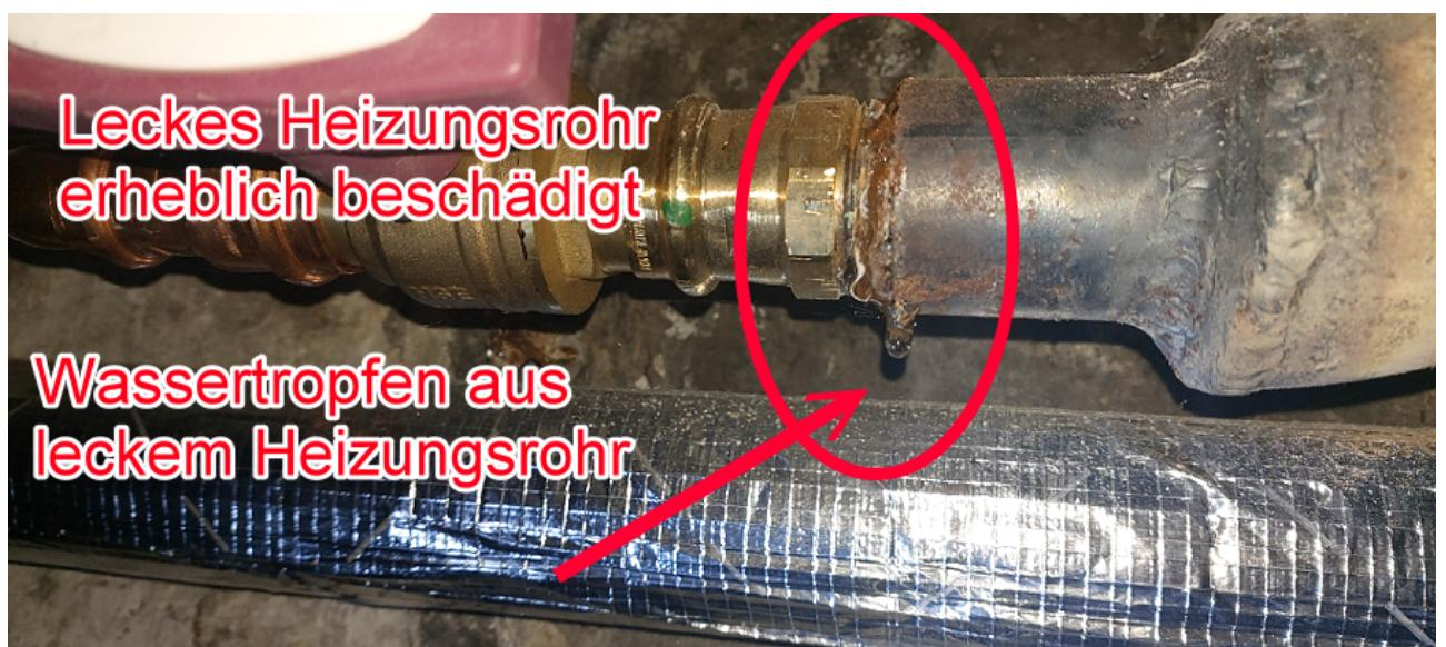
Fotos ab März 2023 , nachdem der Kläger Wassereimer und Wanne unter die lecken Heizungsrohre gestellte hatte Eimer wurde durch den Beklagten mehrfach geleert, war zum Zeitpunkt des Fotos erneut randvoll. Außerdem sind Wasserschäden bzw. Spuren zu sehen, bevor das Heizungswasser aufgefangen wurde
