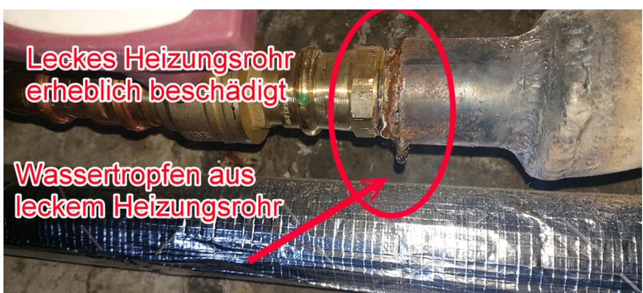
Foto 4 – wie Foto 3: Markierung des größeren Heizungsrohres: weiterer Druckverlust, selbst wenn Wasser im Heizkreislauf enthalten gewesen wäre = nicht herausgetropft wäre
