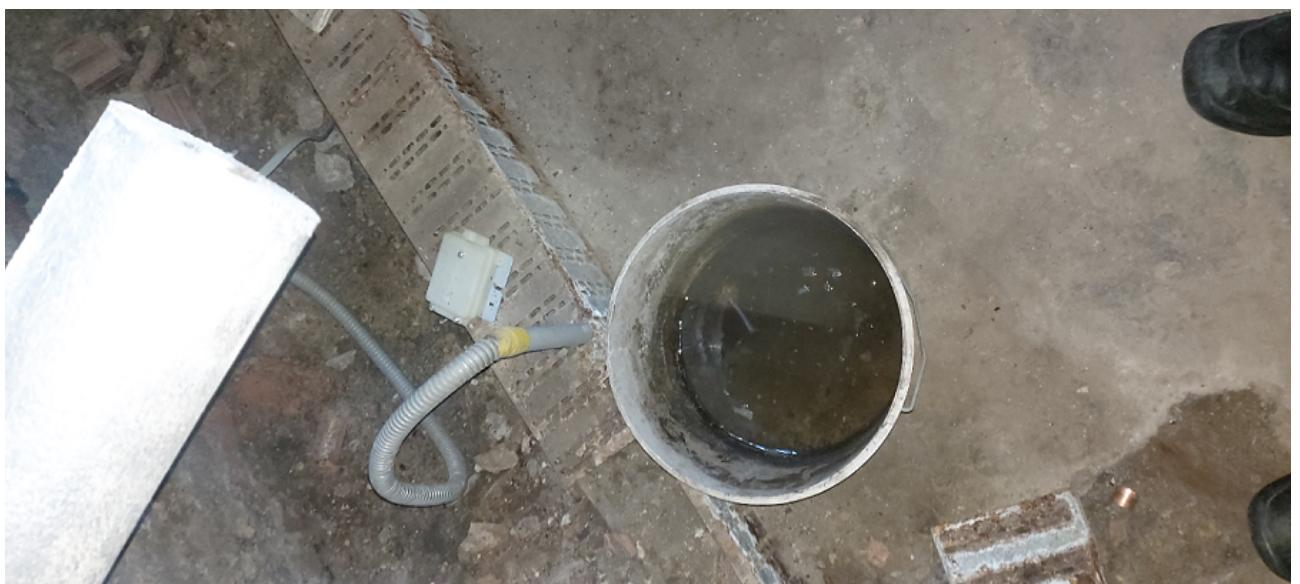
Wanne mit Heizungswasser direkt unter Therme – unabhängig von leckenden Heizungsrohren.
